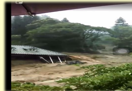
洪水氾濫沖毀山中傳奇設施
